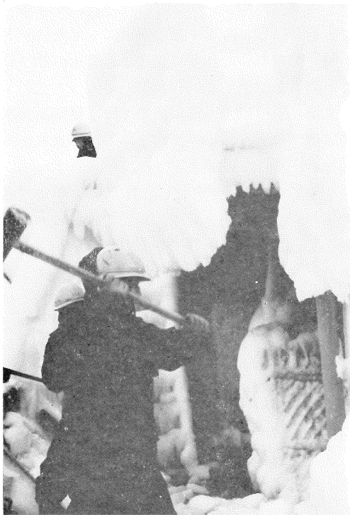
掛矢による除氷作業
