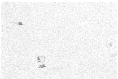
写真—10 すっかり雪の下に埋まった旧アムンゼン・スコット南極点基地、煙突と換気孔がみえる
