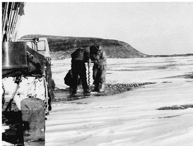
写真-3 海氷に穴をあけ、海底測深（沿岸調査）
