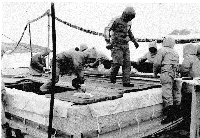
写真-2 10kl 水タンク内張り、張り替え作業（中条）
