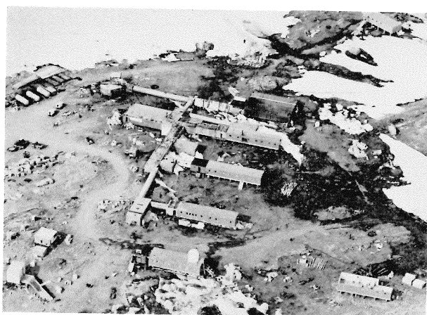
昭和基地、右下が建設中の地学棟
