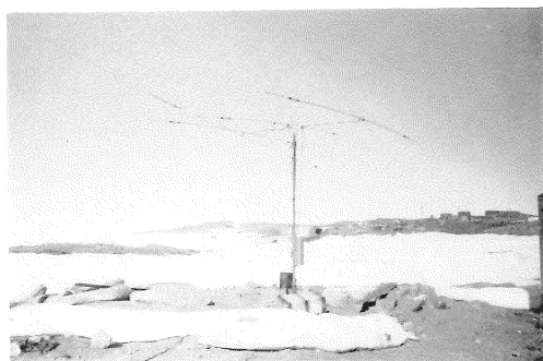
写真-2 アマチュア用八木アンテナ (AS-33)
