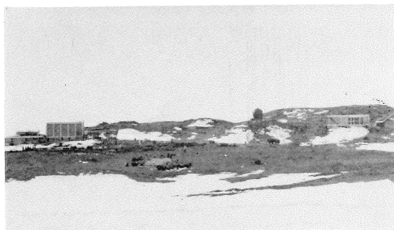
写真-8 オングル島海成段丘(基地のいろんな建物は海成段丘上に建設されている)
