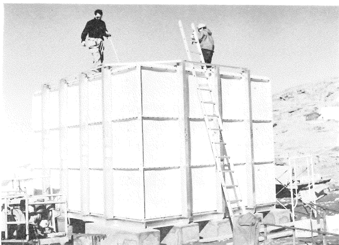
写真—2 新しくできた FRP 製 60 kℓ 油タンク
