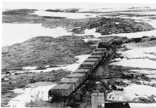
写真-1 ケーシー基地の全景
