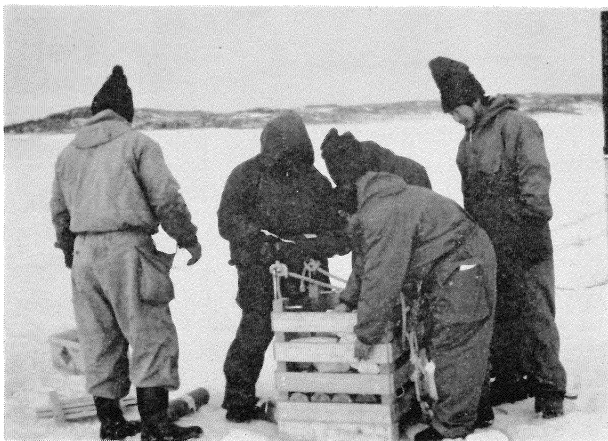
写真—3 100 kg のダイナマイトによる海中発破の準備
